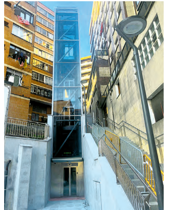
□ Aspecto del nuevo ascensor.
