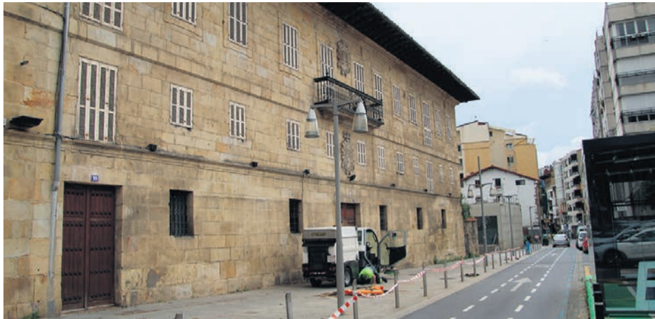
Trabajos en la residencia.
